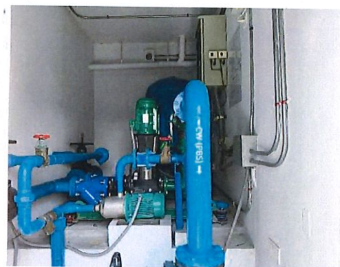
ภาพที่ 16 ระบบสูบน้ำในอาคาร
